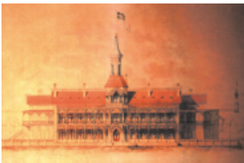
位於銅鑼灣的香港鑄幣廠，於 1864 年興建，1868 年關閉。 The Hong Kong Mint at Causeway Bay, constructed in 1864, closed down in 1868.
